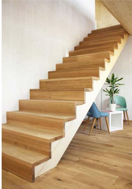
aufgesattelte Tritt- und Setzstufen, Eiche geölt
