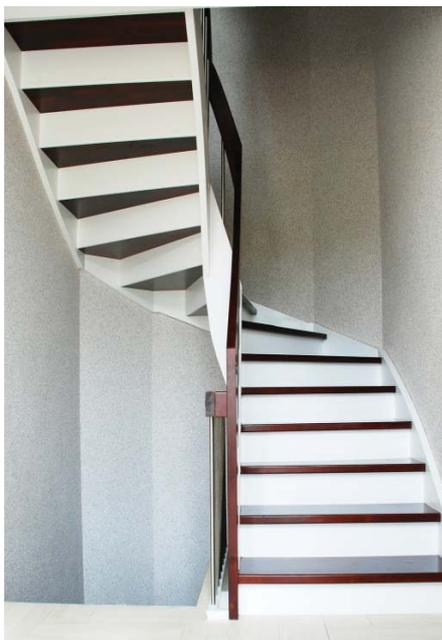
Wandwange mit Tritt- und Setzstufen
