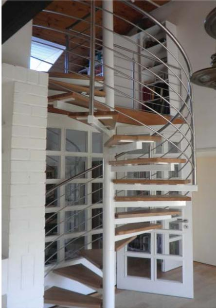
Spindeltreppe Stahlkonstruktion mit Holzstufen
